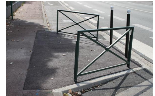
^ Aménagement d'une avancée de trottoir
